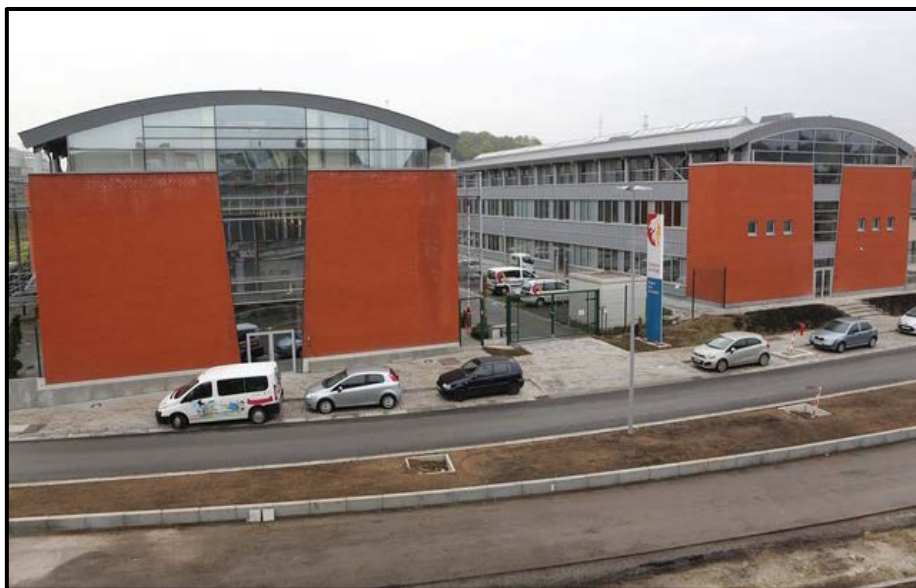
Façade de la Maison de la Formation, rue Cockerill
