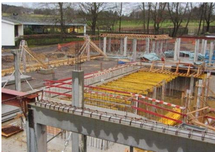
Campus La Reid : un chantier de 2 ans
