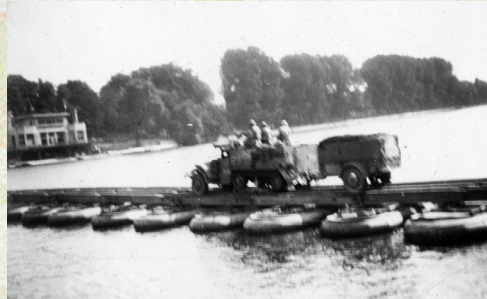
Lüttich, Pontonbrücke vor dem Jardin d'Acclimatation
