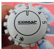
Les vannes thermostatiques placées sur les radiateurs commandent l'entrée d'eau chaude permettant une régulation de la température ambiante de chaque pièce. Les chiffres ou symboles (0, 1, \*, 2, 3, 4, 5) imprimés sur la vanne symbolisent différentes plages de température.
