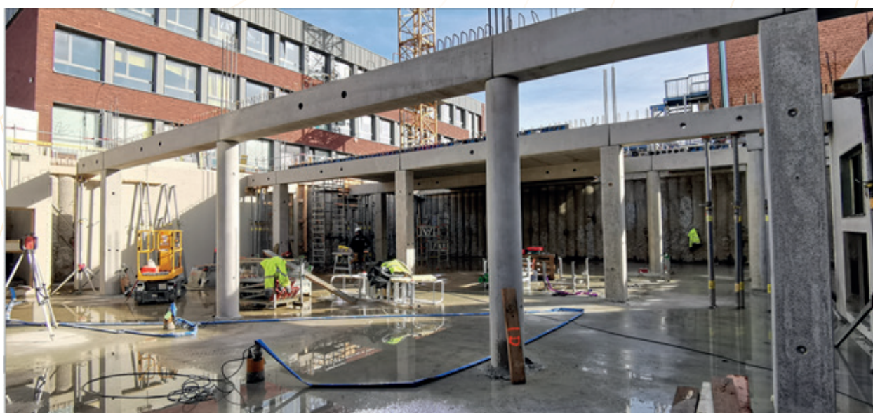
EP Huy – Nouveau bâtiment
