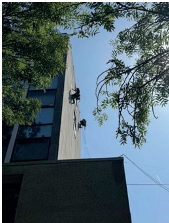
IPES Verviers – Sécurisation des façades – Pignon B1 Réfection joints entre pierres
