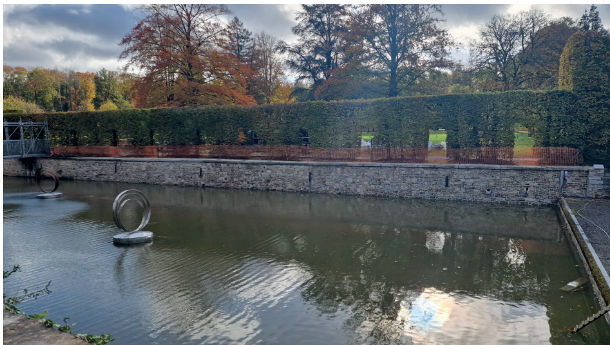
Mur des douves après restauration
