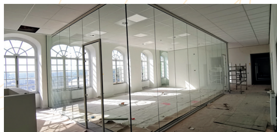
Saint-Laurent – Pose des revêtements de sols et fermetures des faux plafonds
