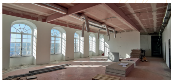
Saint-Laurent – Cloisons vitrées de la salle de réunion du 1 er étage
