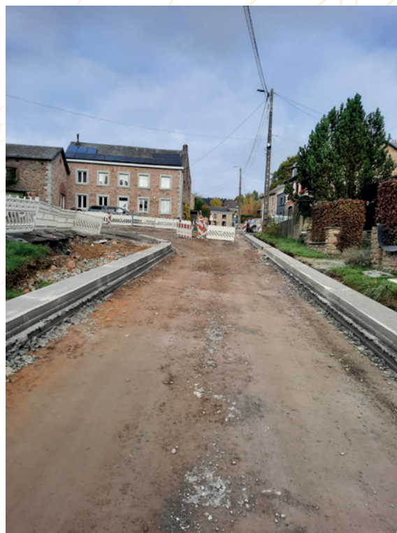
Stoumont – Réfection de la voirie et de l'égouttage dans le village de Chevron – Phase 2
