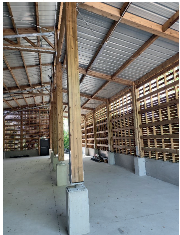
La Reid – nouveau hangar
