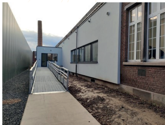
PSE Saint-Laurent – Passerelle d'accès
