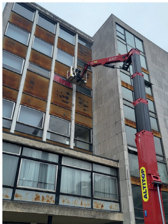
IPES Verviers – Sécurisation des façades Arrière B2 – Réfection joints chassis
