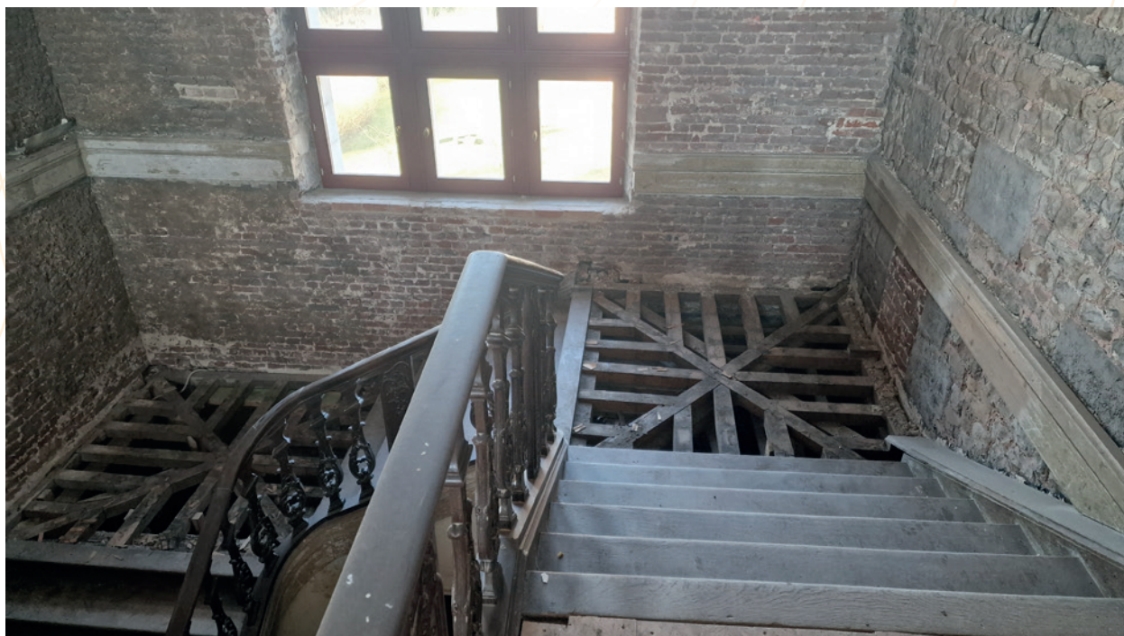
Démontage des paliers
