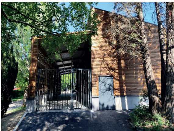
La Reid – nouveau hangar
