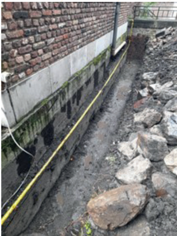
PMVW – Assainissement des murs
