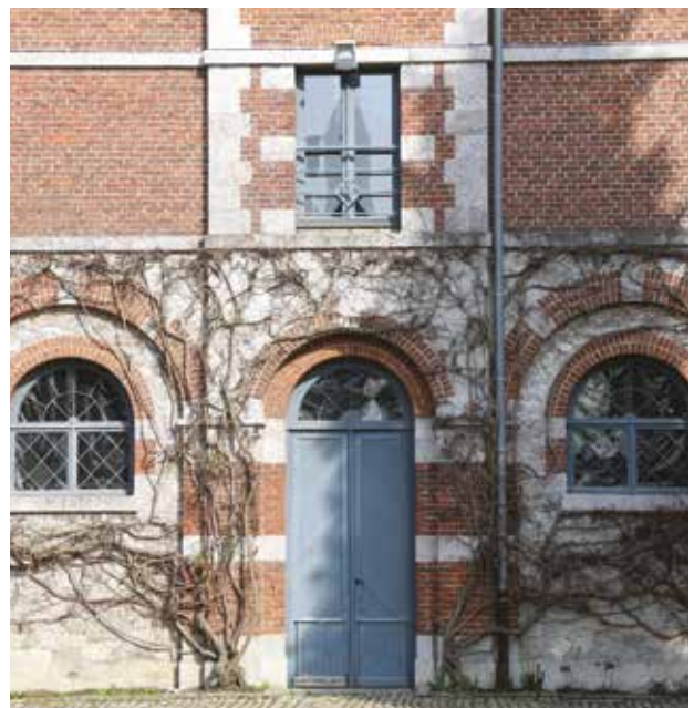
Dépendances, façades côté cour
