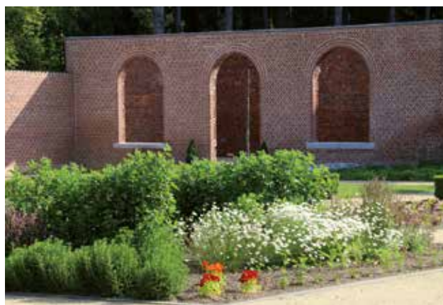
Vue de l'orangerie du Château de Jehay
