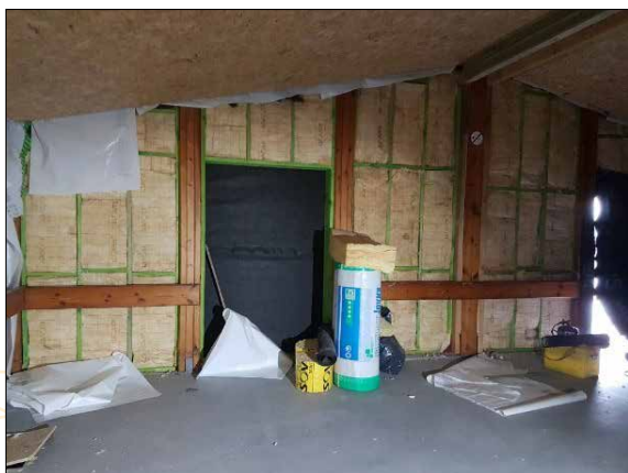
Isolation d'un mur en cours
