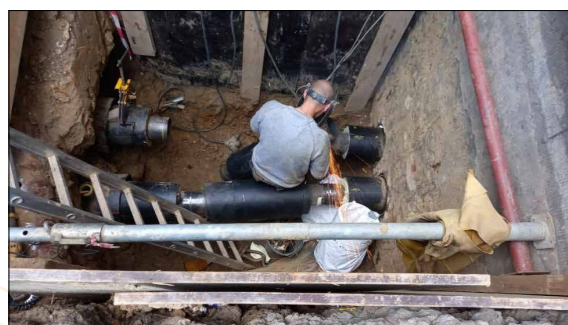
Pose des tuyauteries en sous-sol pour alimenter le réseau de chaleur
