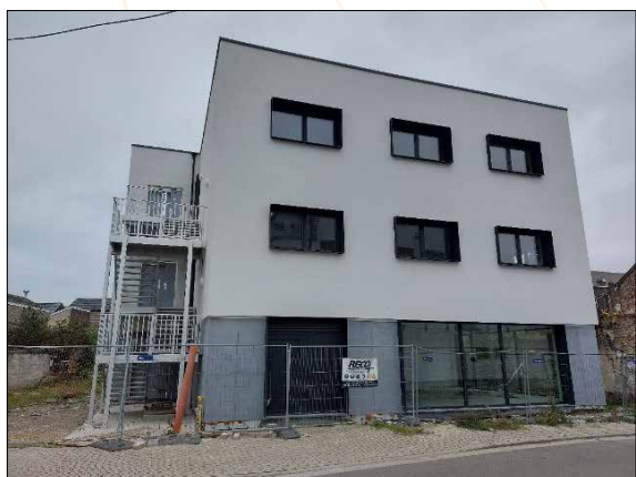
Création de kots à Jemeppe
