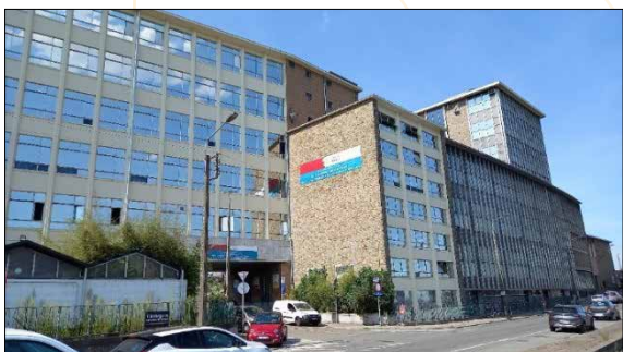
Rénovation de la façade à Herstal
