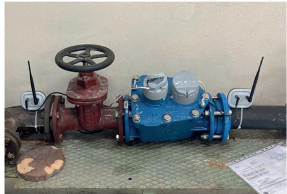
Placement d'un appareil de télérelevage sur une conduite d'eau
