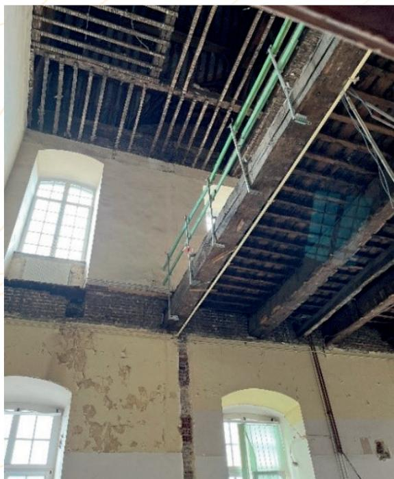
Saint-Laurent – Dépose des plafonds et percements des planchers pour y placer les futures cages d'escalier
