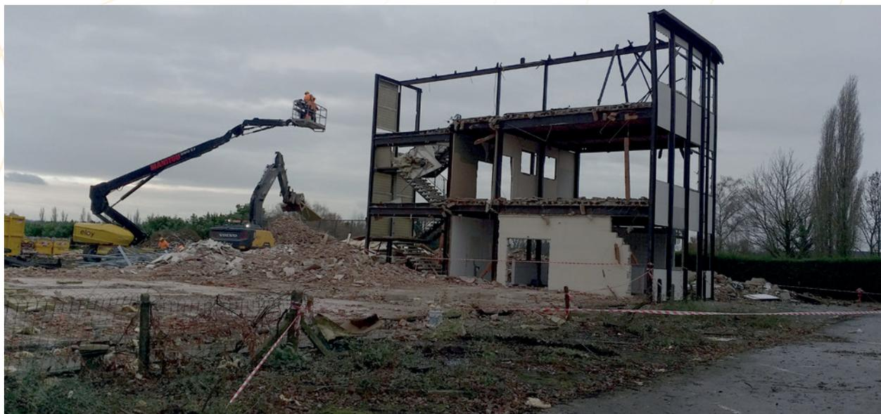
Bâtiment de deux niveaux en structure métallique en cours de démolition
